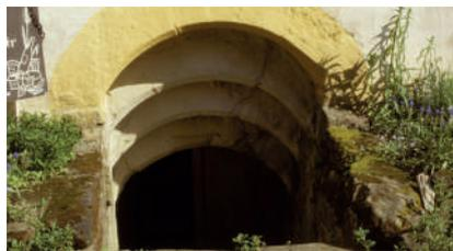
Châtillon-sur-Saône (Vosges) : au sud du département des Vosges, à proximité de celui de la Haute-Saône, apparaissent les entrées de cave à quatre arceaux, décrochés dans l'inclinaison de la descente.
