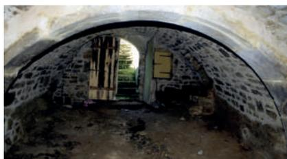
Châtillon-sur-Saône (Vosges) : l'arrière et l'avant d'une même cave dont la voûte est soutenue par un arceau. À l'avant, joints de pierre beurrés, mais non à l'arrière ; sol de terre battue.
