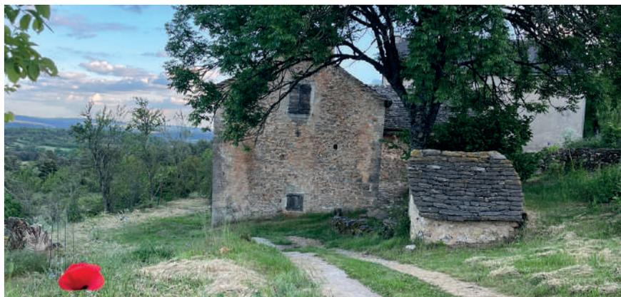
Façade nord de la bâtisse et arrière du four à pain ; couverture en lauzes de calcaire réparée.
