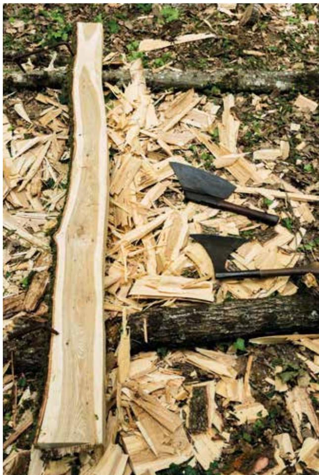
Équarrissage en forêt d'une colombe par le charpentier Léonard Rousseau.
