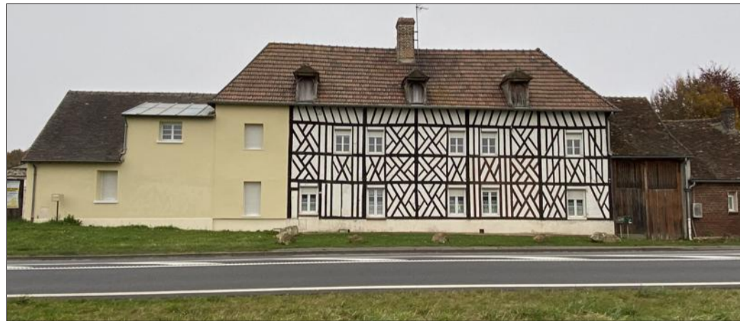
Un cas d'isolation extérieure partielle sur une maison ancienne dans le Val d'Oise : celle-ci est partagée entre deux propriétaires, l'un respectueux des caractéristiques du bâti, l'autre, à gauche, qui s'est laissé séduire par une proposition d'isolation à un euro, laquelle provoquera un pourrissement accéléré du bâtiment. Document remis/Photo Maisons paysannes de France
