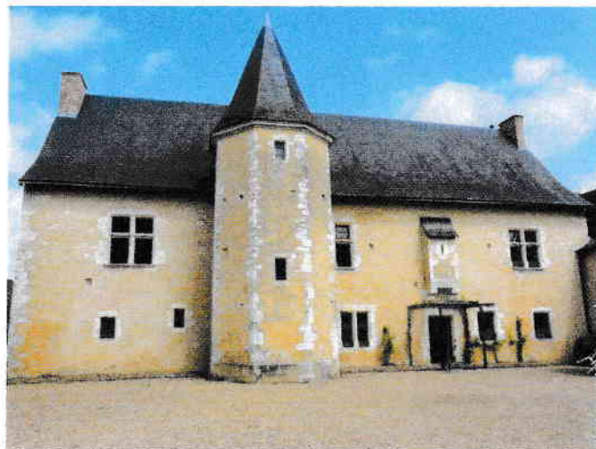
IMAGE 14 – Façade sur cour
