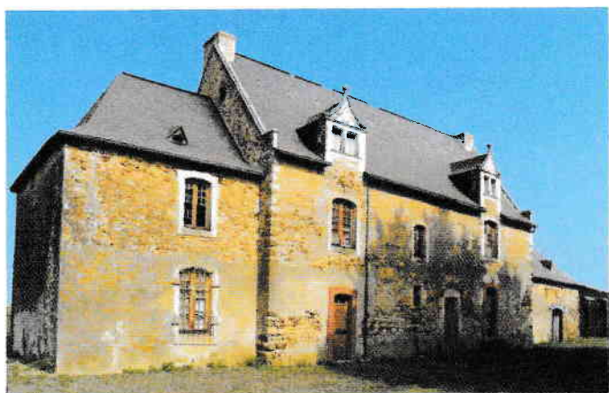
IMAGE 1 – Façade sur cour
