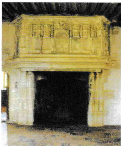
IMAGE 13 – La cheminée du rez-de-chaussée
