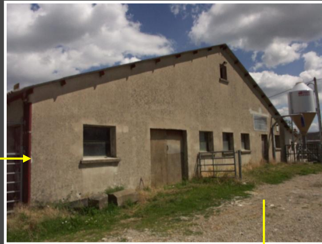
1971 : construction d'une stabulation entravée pour 100 animaux
