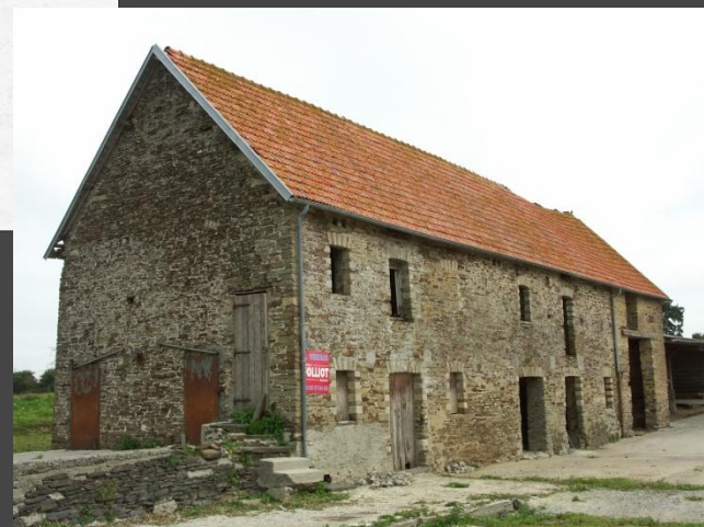
Etable, charreterie, grenier (centre Manche) à vendre 90 000 € (2006).
