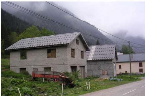
fig. 20. : bâtiment stockage foin annexe à l'exploitation A, récupéré en 2000 / murs parpaings apparents et toiture bacs acier (source EBA 38).
