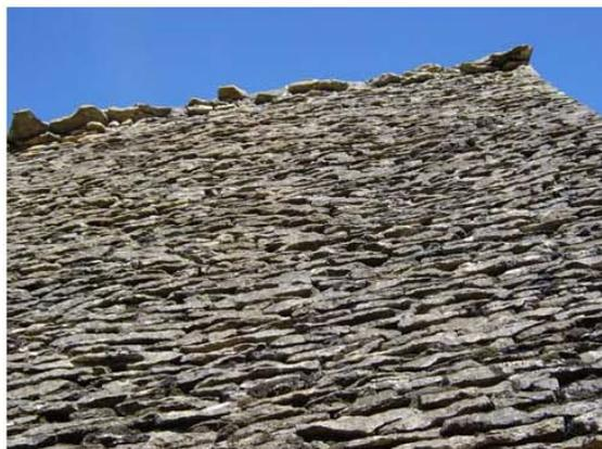
fig.12. : Bâtiment ancien, toiture lauze (exploitation G / source EBA 24)
