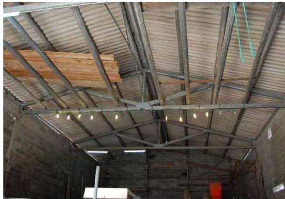
fig.28 : Structure en auto-construction avec poteau électriques métalliques (exploitation H / source étude EBA 34).
