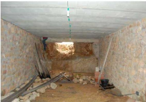
fig.33 : Cave en cours de construction avec parements pierre (exploitation H / source étude EBA 34).
