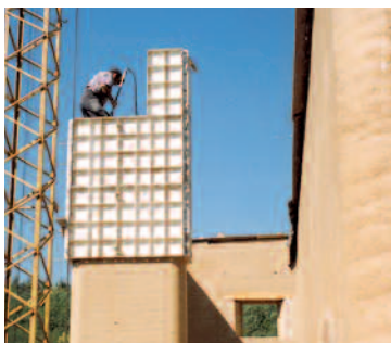
La terre est damée entre les coffrages métalliques.
