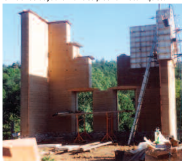
Les trumeaux s'élèvent en fonction des ouvertures.
