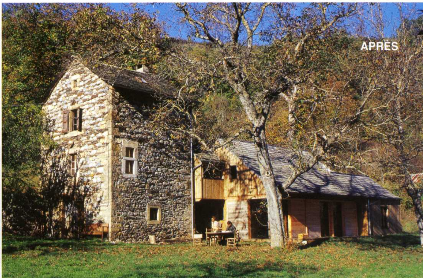
Un passage couvert relie le nouveau bâtiment à l'ancien.
