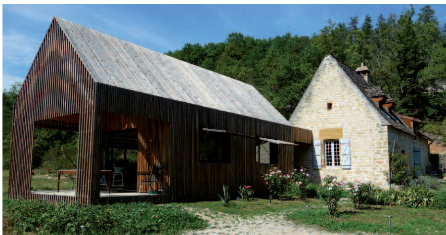
La jonction des deux parties respecte la présence de la bâtisse primitive.
