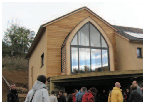
Interprétation de la voûte caussenarde sur une maison ossature bois BBC lors du forum bois en octobre 2010 (Nathalie Crépin architecte).
