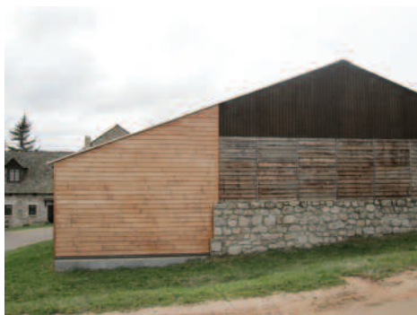
Hangars agricoles en bois. Le développement s'est étendu sur tout le département.
