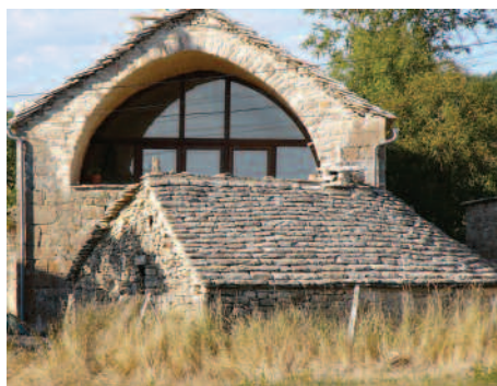
Serre passive dans une voûte du causse et en vallée du Lot.
