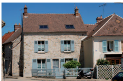
Côté rue après travaux.
