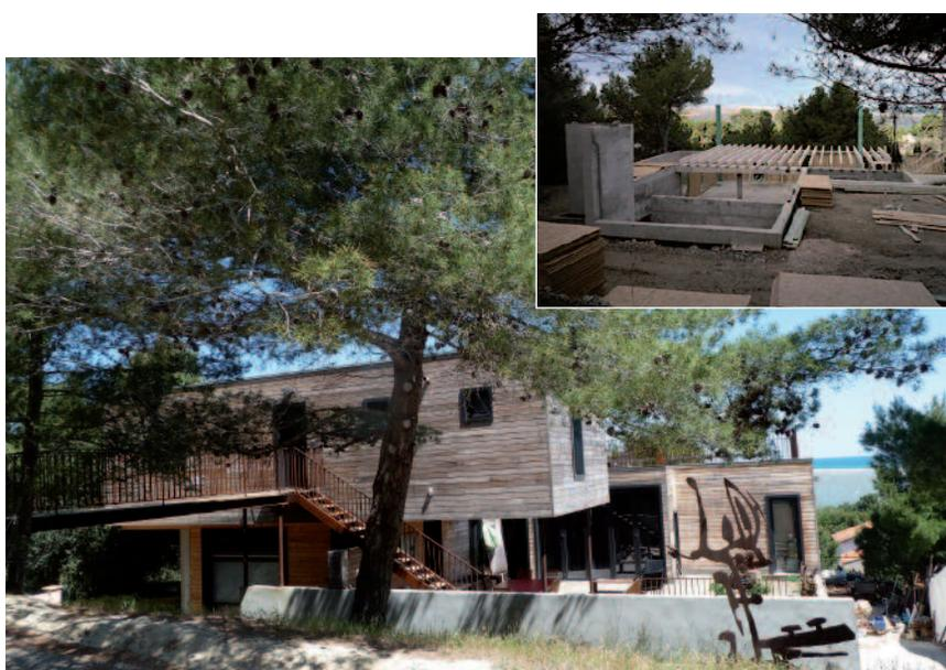
Leucate – Insertion de la construction dans les pins maritimes. En haut : socle semi-enterré et structure bois.
