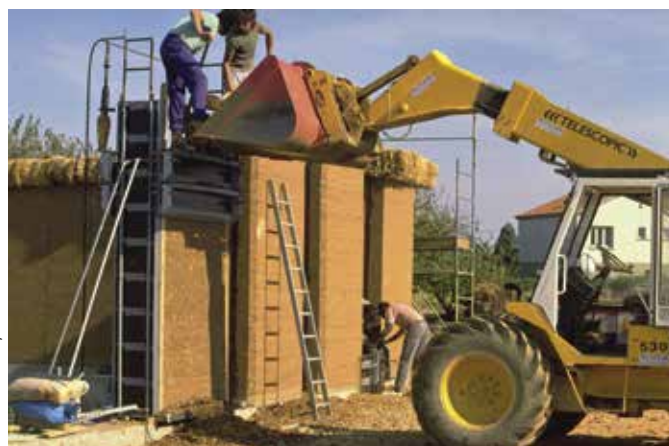
Construction moderne en pisé.
