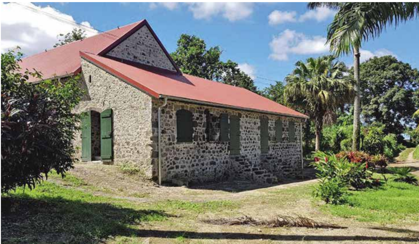
Sur un pignon, le logement ajouté postérieurement à la construction de la halle a été restauré lui aussi.
