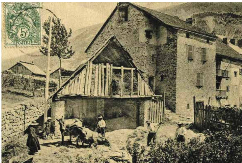
Le toit à forte pente de la remise d'aire à fouler permet de ménager un important volume de stockage des gerbes (Foulaison à Beauvezer vers 1900).
