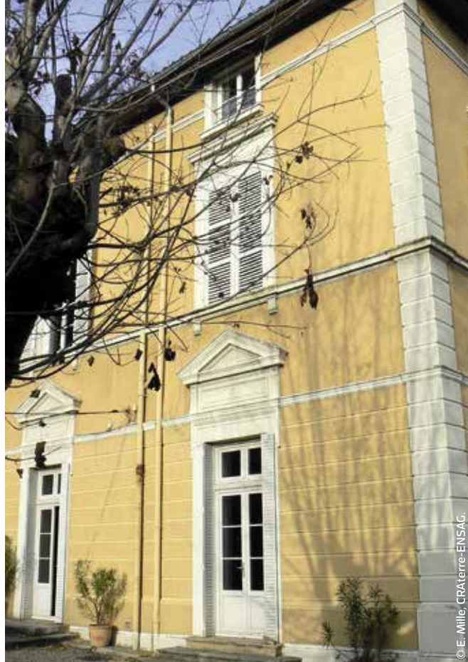
Mur pignon d'un immeuble dit « Canut » construit en pisé de terre et de mêchefer vers 1870, rue Coste (Caluire-et-Cuire).
