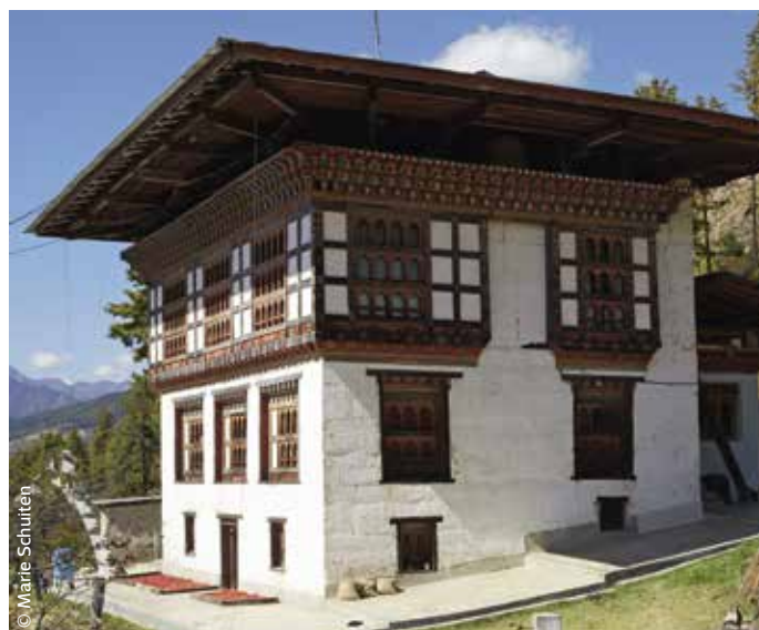
Maison récente, bâtie en pisé au Bhoutan.
