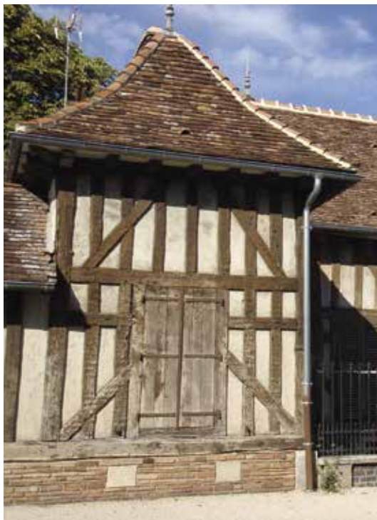
Petite aile d'un bâtiment en torchis/pan de bois à Piney (Aube)
