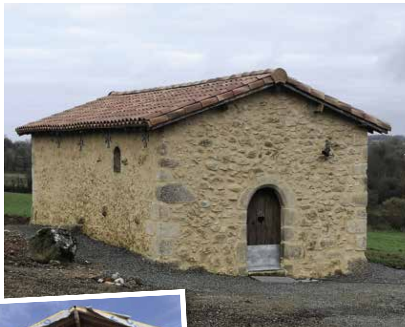
La chapelle après restauration.
