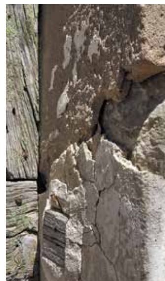
Encadrement de porte façonné au mortier de gypse rose et au mortier de chaux (Peyroules).
