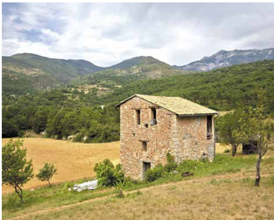
Entrepôt de type fenil sur étable , en maçonnerie de calcaire liée au mortier de gypse rose (Castellane)
