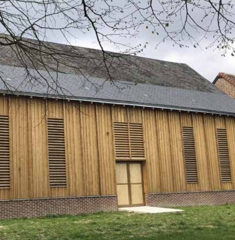
La grange après les travaux. Le torchis est protégé par un bardage de bois.
