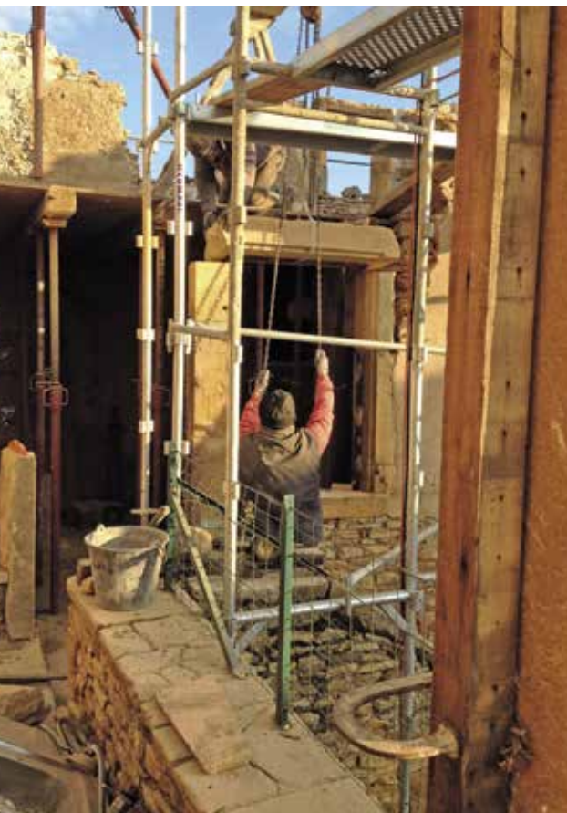
Mise en place d'un linteau.
