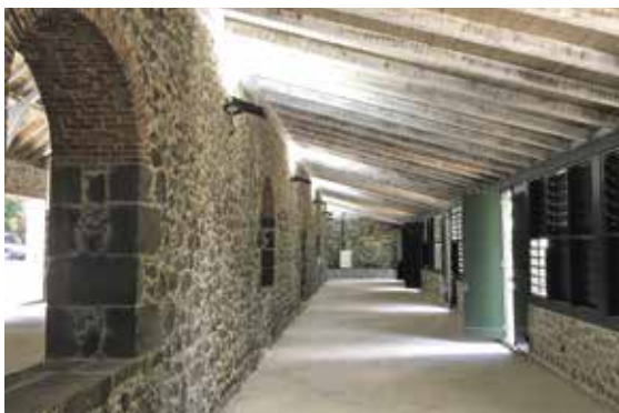
L'appentis joue les galeries le long de la halle principale.
