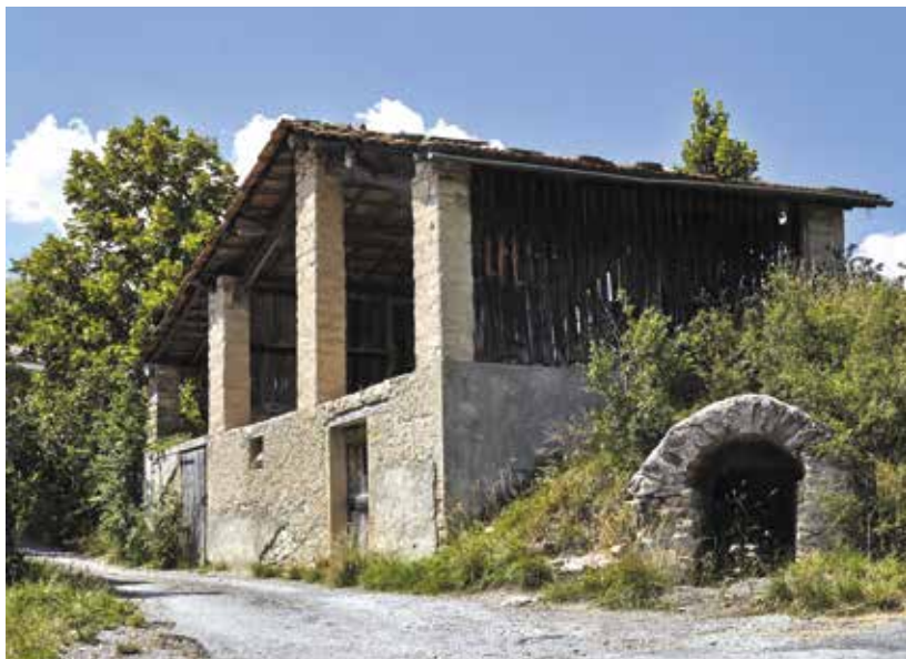
Hangar-fenil composite. Clumanc, Toueste.
