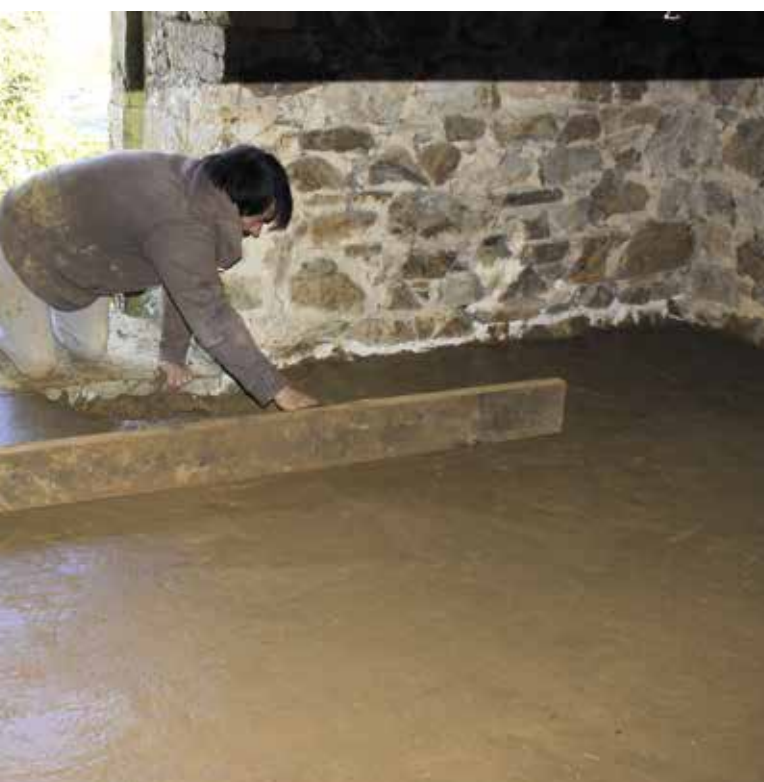
Le soir, après un bon talochage, le sol est terminé.
