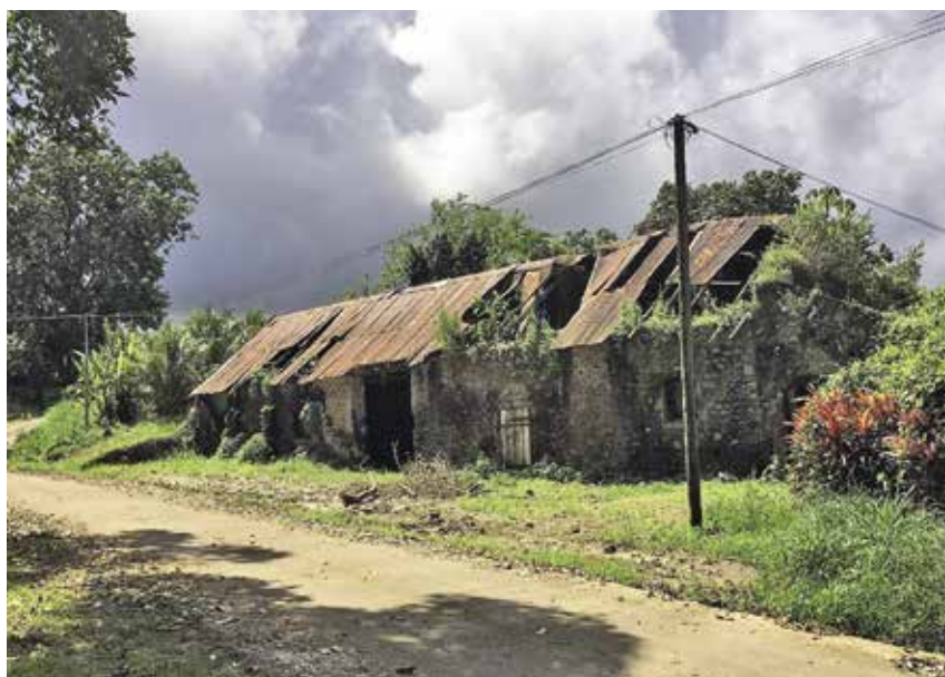
Avant les travaux , il fallait vraiment « croire » dans ce bâtiment pour envisager sa restauration.
