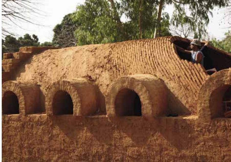
Construction d'une voûte au Sénégal.
