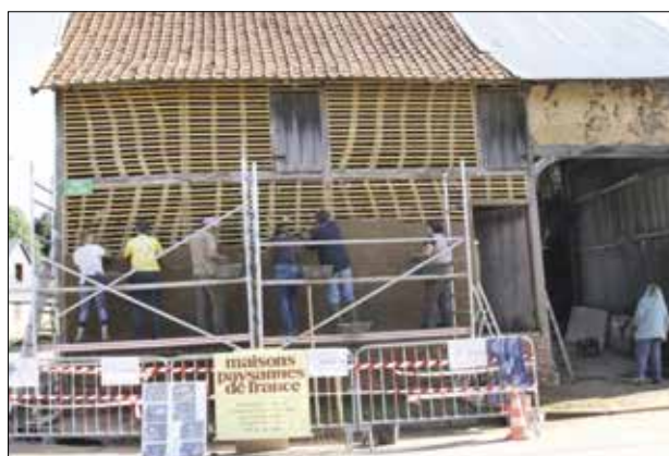
... et recouverte de torchis.
