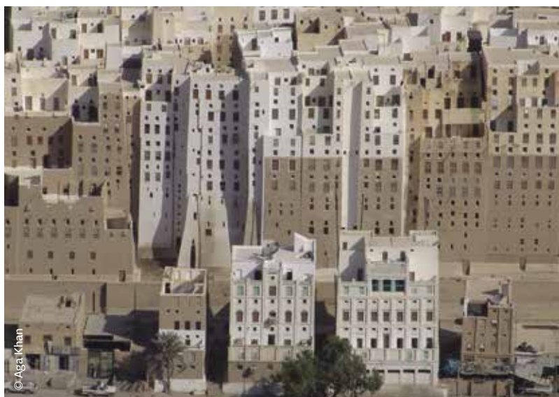
Ville de Shibam au Yémen (classée au Patrimoine Mondial). Tous les immeubles d'habitat sont élevés en terre sur 6 niveaux.
