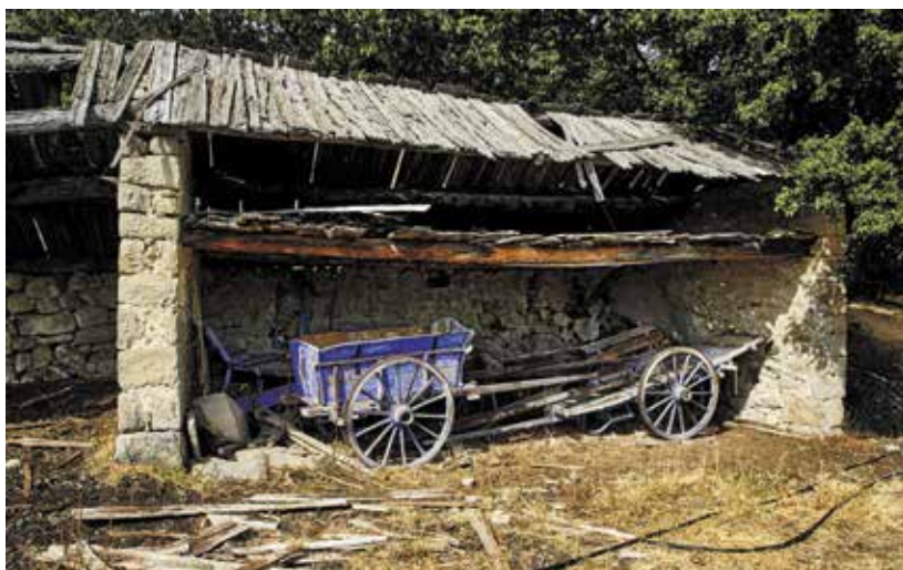
Cette remise d'aire à fouler est une des rares à avoir conservé sa toiture en essentôle (Le Fugeret, la Béouge).
