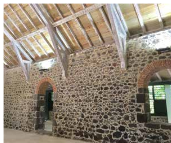
La réfection des joints à la chaux.
