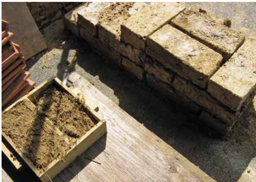
Cette technique de moulage très simple a été utilisée sur tous les continents. (CFP MPF)
