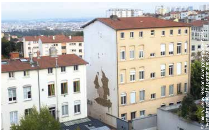
Ancien asile d'aliénés, puis Clinique de Champvert. Aile des femmes, construite vers 1840 en pisé de terre enduit sur soubassement de pierre, démolie dans le cadre d'un projet immobilier en 2016.
