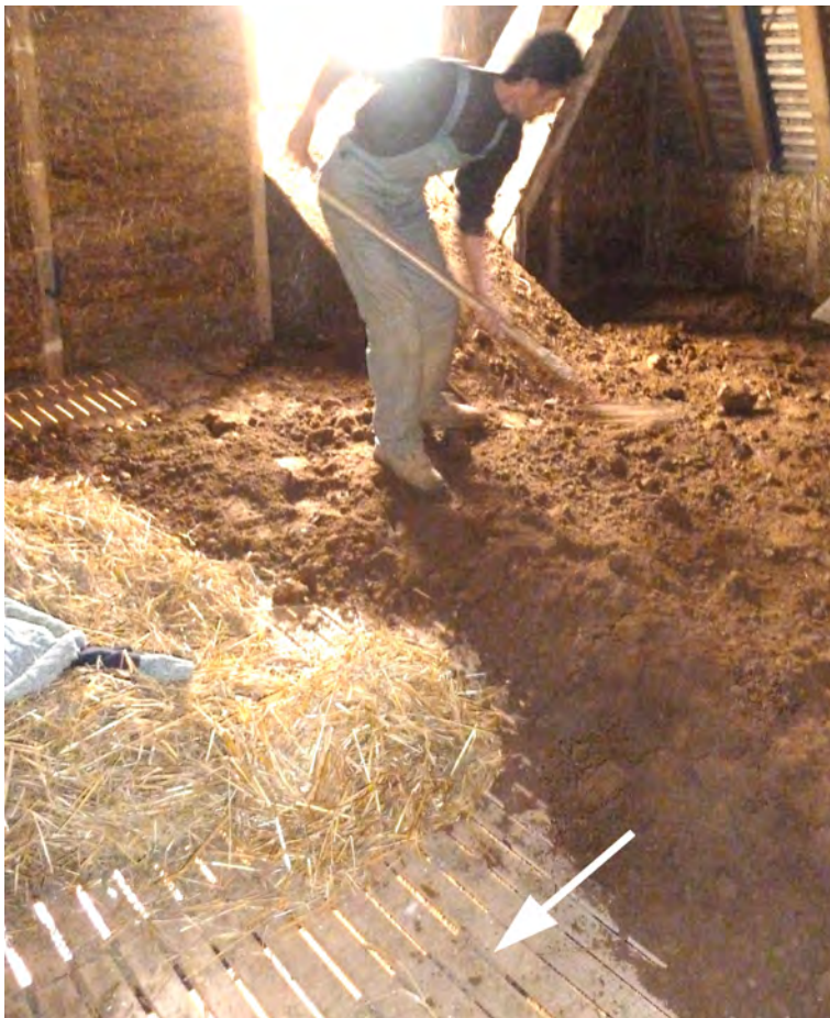
Illustration 26: un lattis au sol formant plancher non jointif, vu de dessus. Avant la pose de la chape sèche (Sophie Popot)
