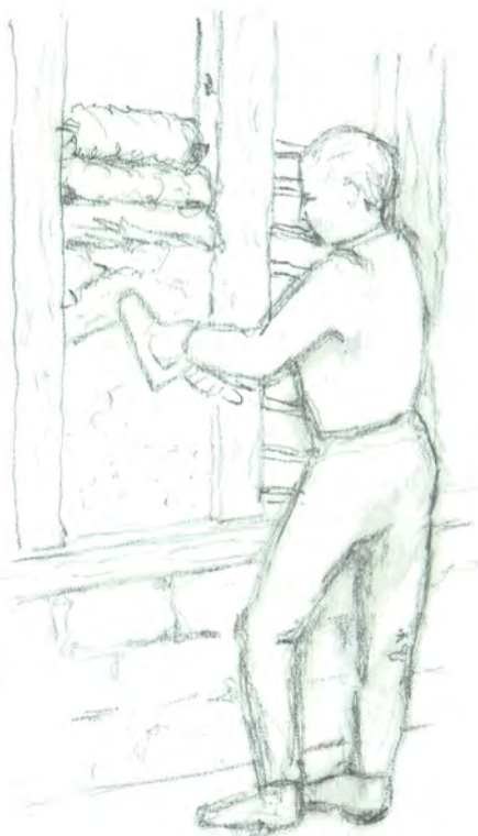
Illustration 31: Finition d'égalisation après pose à cheval ou pose en fusées.
