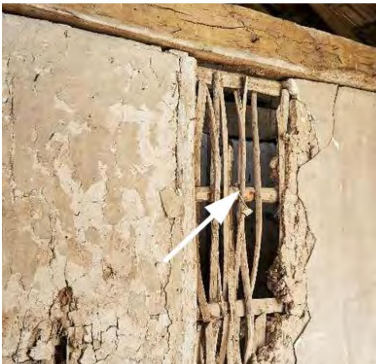
Illustration 24: Clayonnage composé de palançons horizontaux en première trame et de baguettes verticales en 2e trame. (©Région Grand Est - Inventaire général/Ph.B.Drapier)
