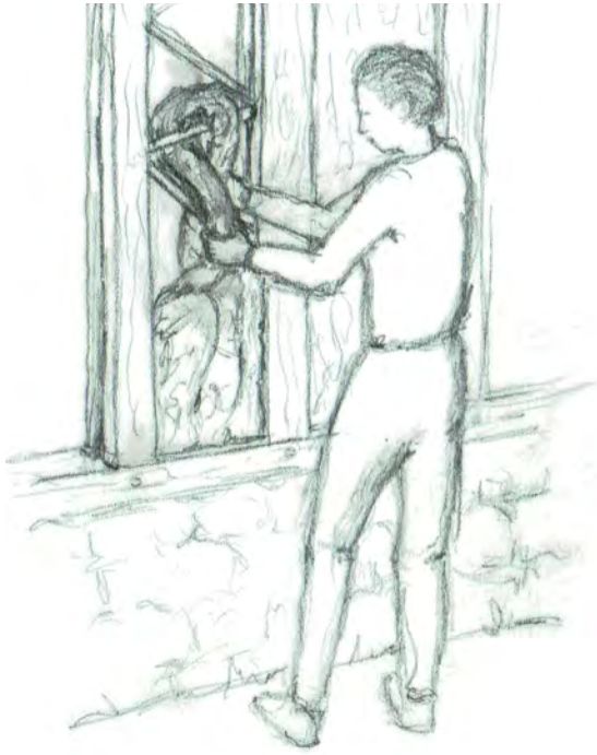
Illustration 32: Pose tressée : Soit les pailles sont imprégnées dans une barbotine puis torsadées, elle formes alors une La longue torche de torchis à l'état plastique est tressée sur le support. Soit elles sont réalisées avec une corde de paille sèche, la pose se réalise tressée sur le support. Finition d'égalisation ou de remplissage avec un enduit de torchis plaqué.
