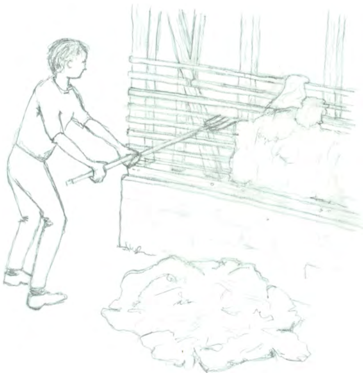
Illustration 33: Pose projetée / rabattue :La personne se met à une certaine distance et projette avec force. Ce type de pose s'effectue parfois directement à la fourche. Il existe aussi des projections mécaniques. Finition par pression verticale.
