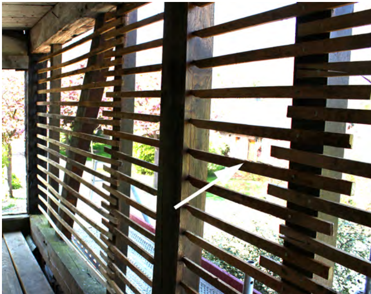
Illustration 16: Lattage formant lattis par endroit (Yan Minne)
