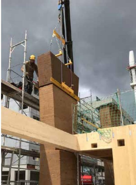
La structure intérieure est en bois, en appui sur les piliers.
