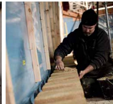
**Mise en œuvre de briques de terre compressées**, en pied de voûte sur 1m80 de haut, afin de réguler l'hygrométrie du lieu.
