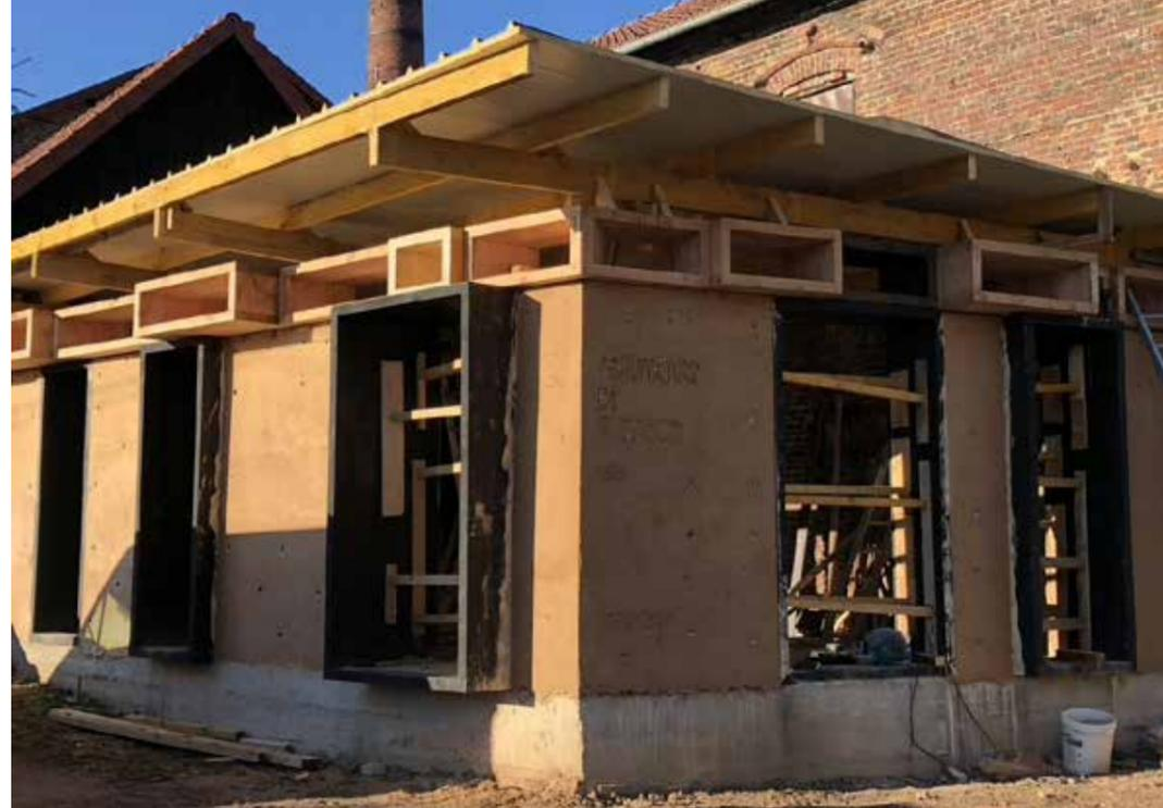
**Bâtiment en cours de finition** : larges débords de toiture en attente de revêtement de finition, pour protéger les murs de l'eau pluviale. Les murs très épais apportent une grande inertie au bâtiment et dispensent d'isolation intérieure. Les cadres des ouvertures recevront bientôt des vitrages isolants.
