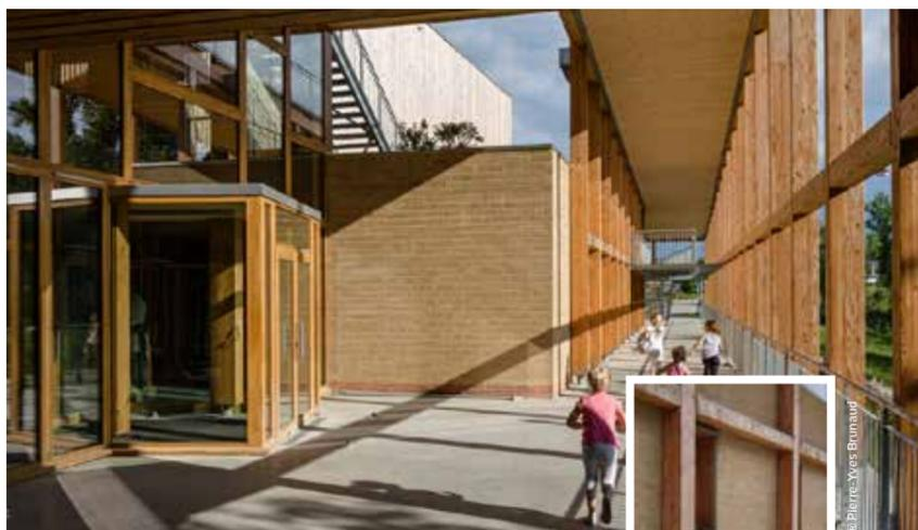
Le Pôle culturel Aria à Cornebarrieu (Haute-Garonne) a un remplissage en briques de terre comprimée dans une ossature en bois. Architectes : Atelier Philippe Madec.
