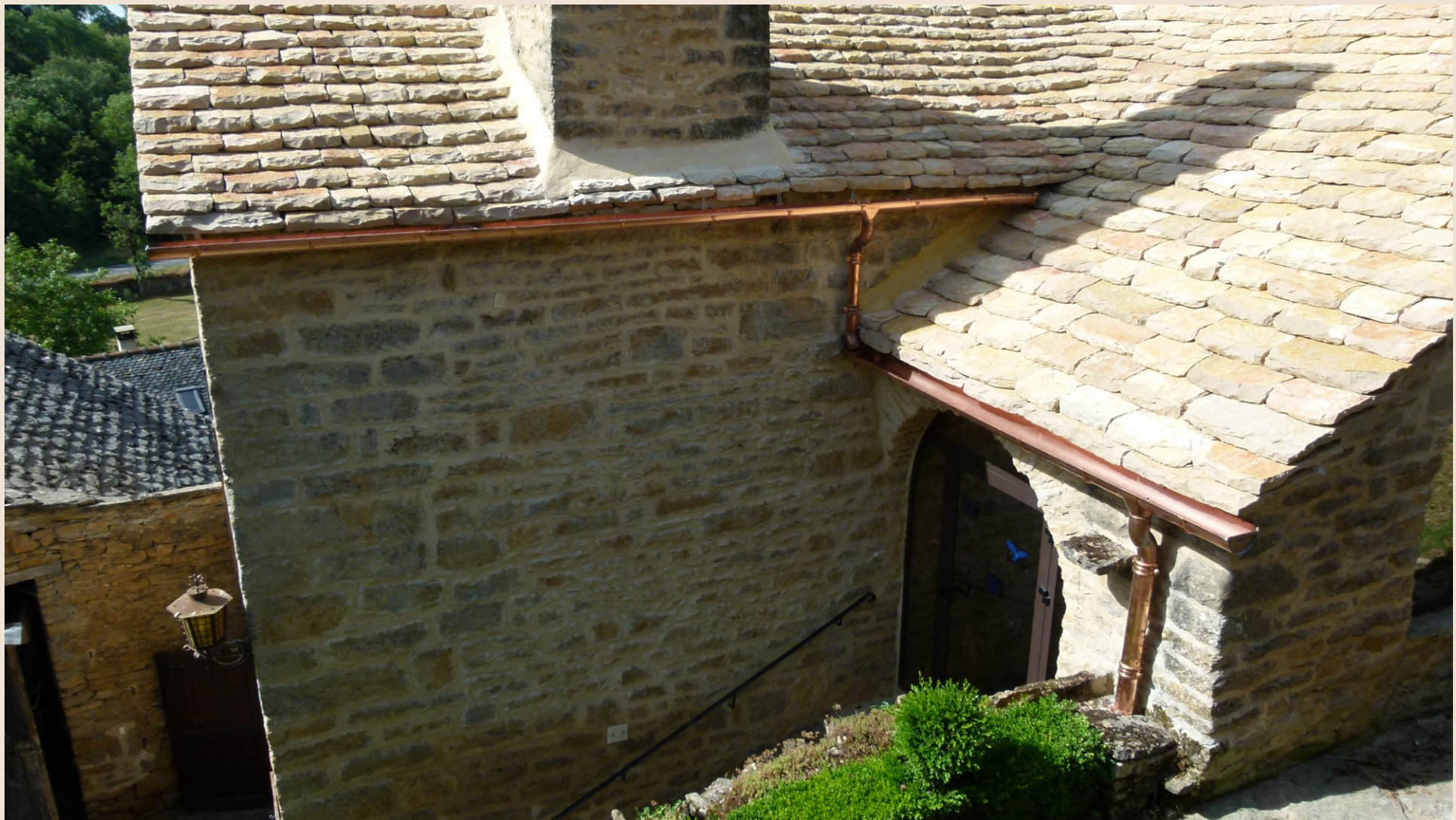
Noue et chéneaux en cuivre
