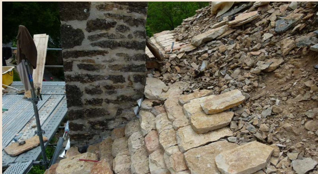
Détail de la pose de lauzes
