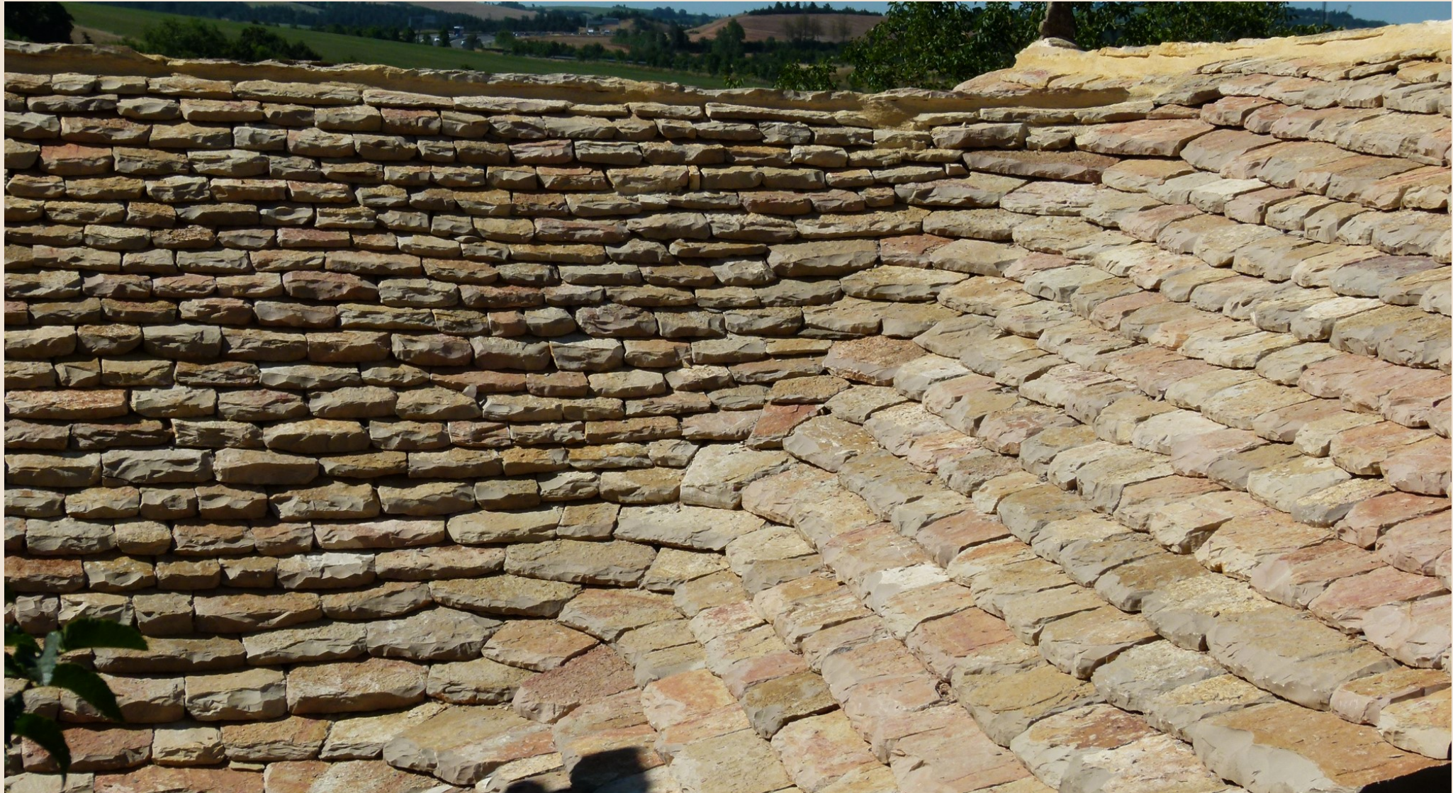
Détail des noues côté nord/est
