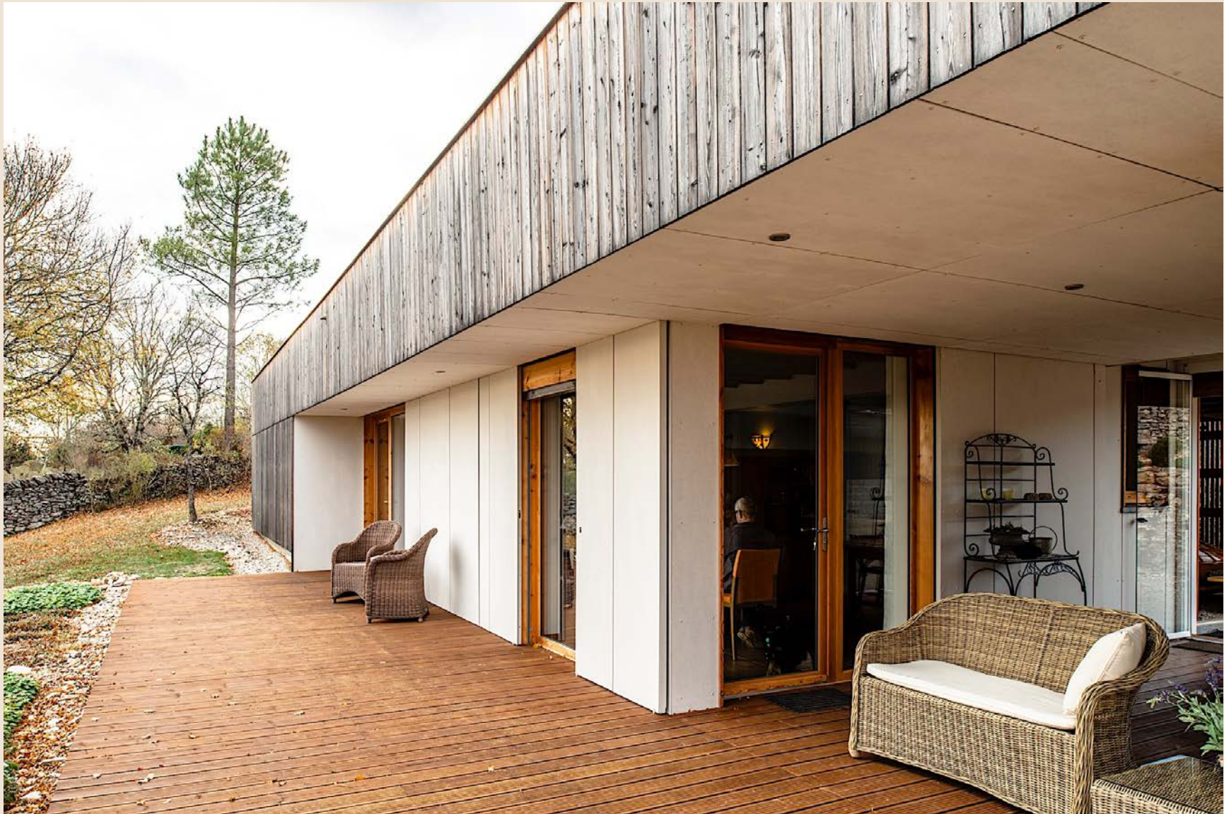
Les grandes ouvertures sont au sud et captent les rayons solaires en hiver sur le paysage
