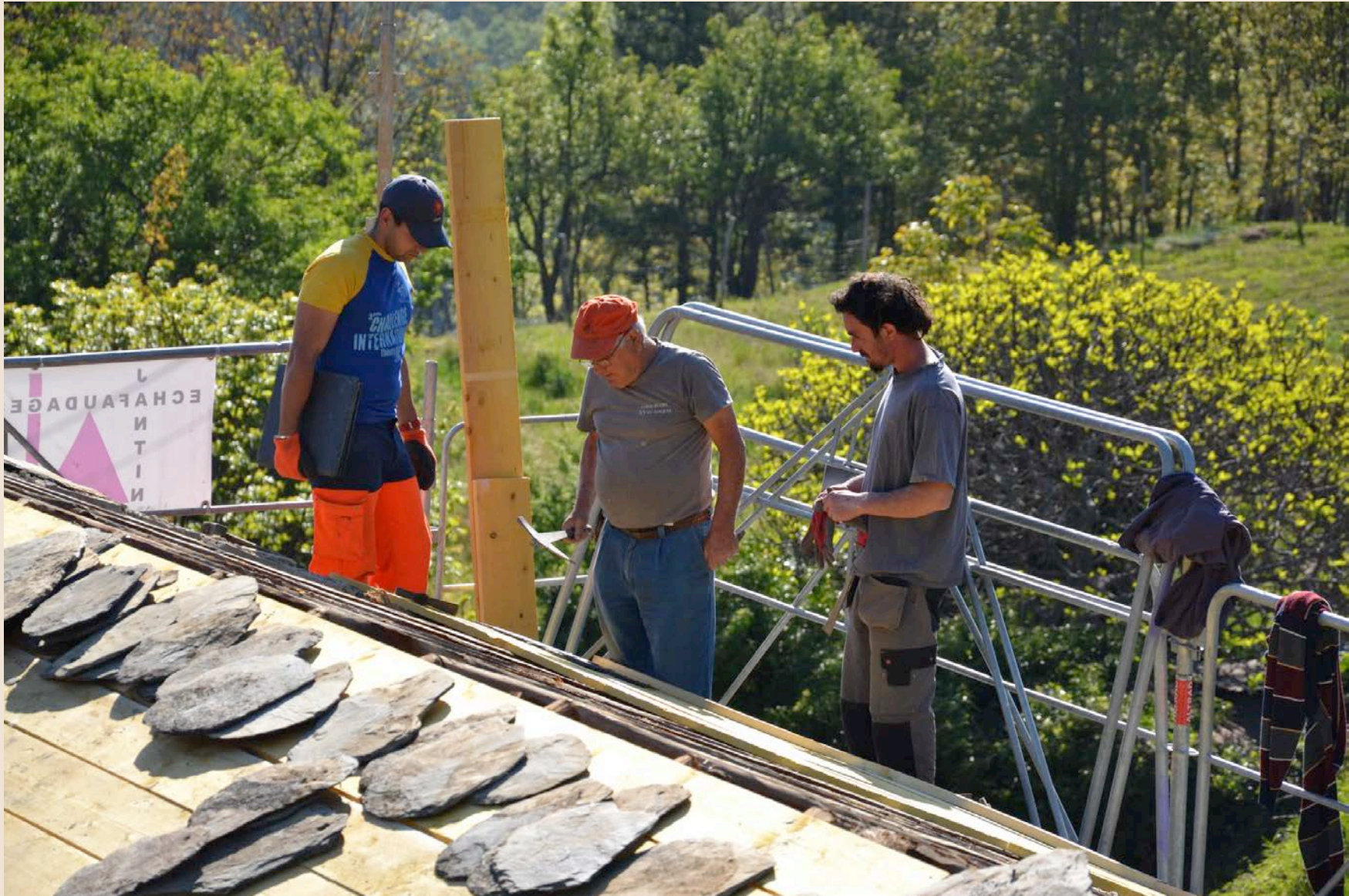
Pose du faîtage
