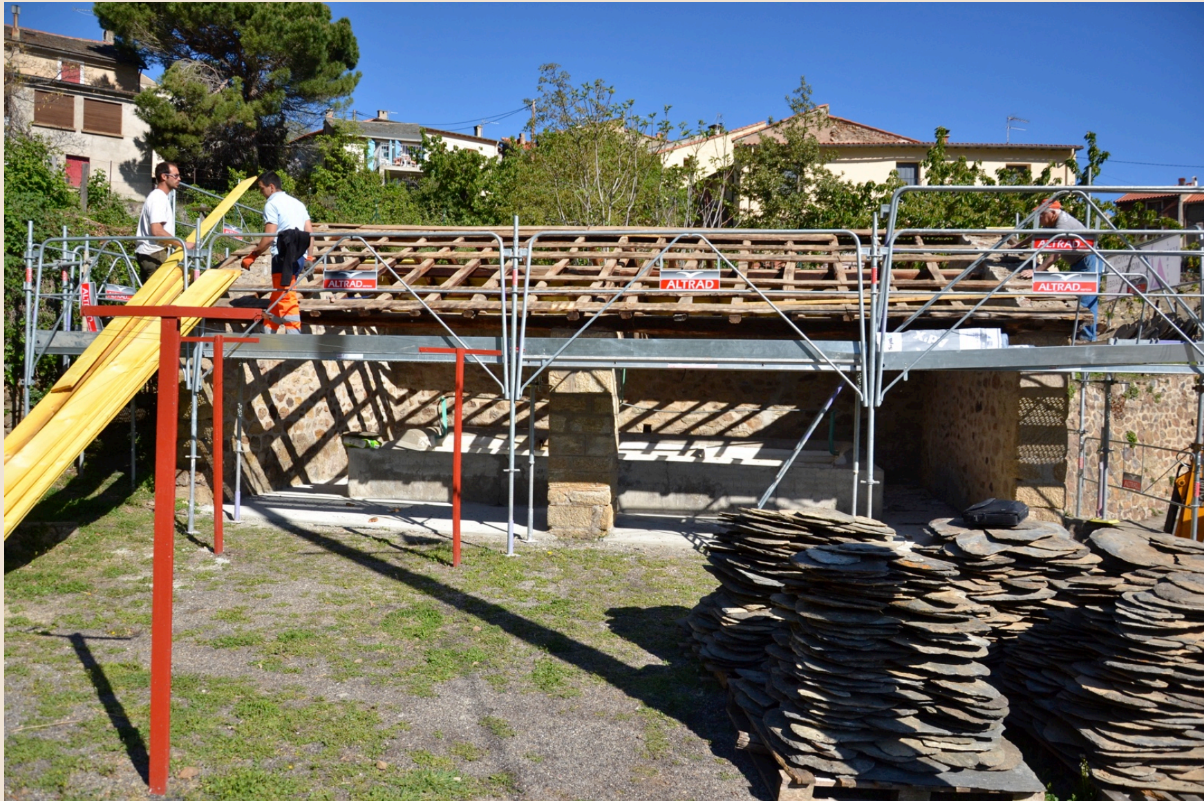
Pose du platelage
