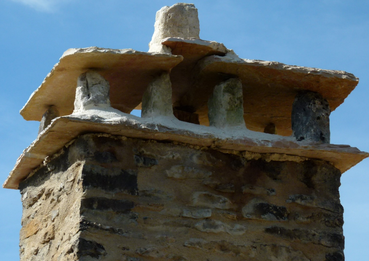
Couverture de la cheminée
