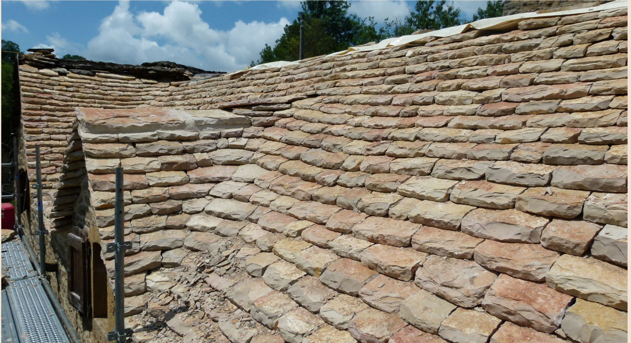
Détail des noues côté sud
