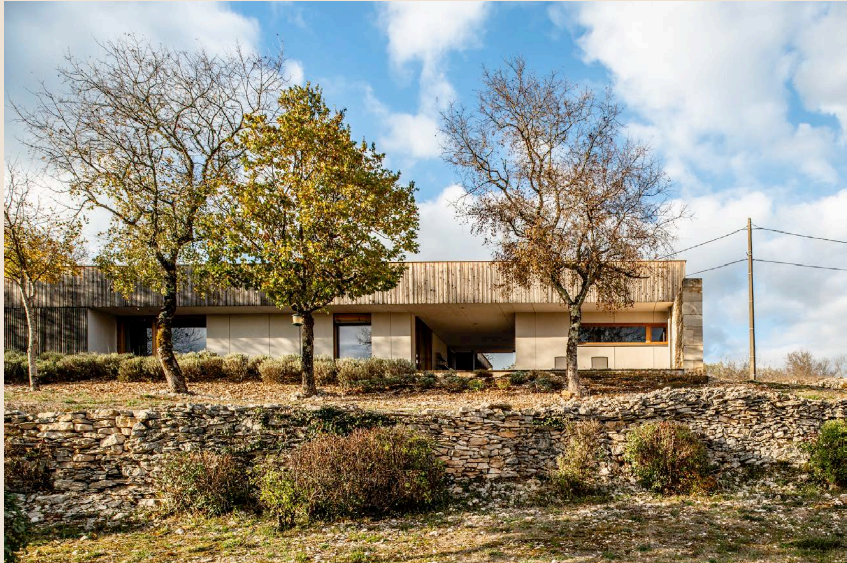
Vue du jardin, l'horizontalité de la maison répond à celle du paysage marqué par les petits murets de pierre
