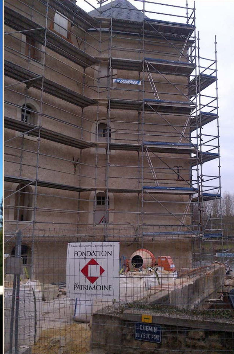
Échafaudage façade sud
