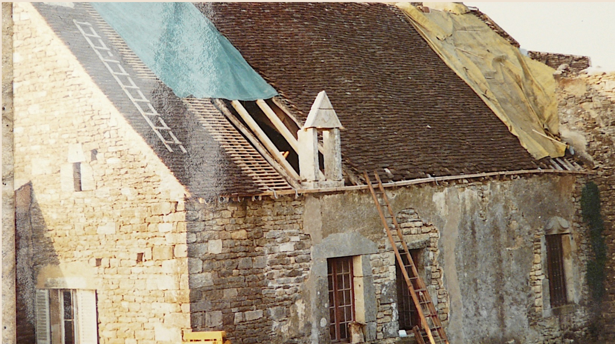
Pose d'un chien assis - nord
