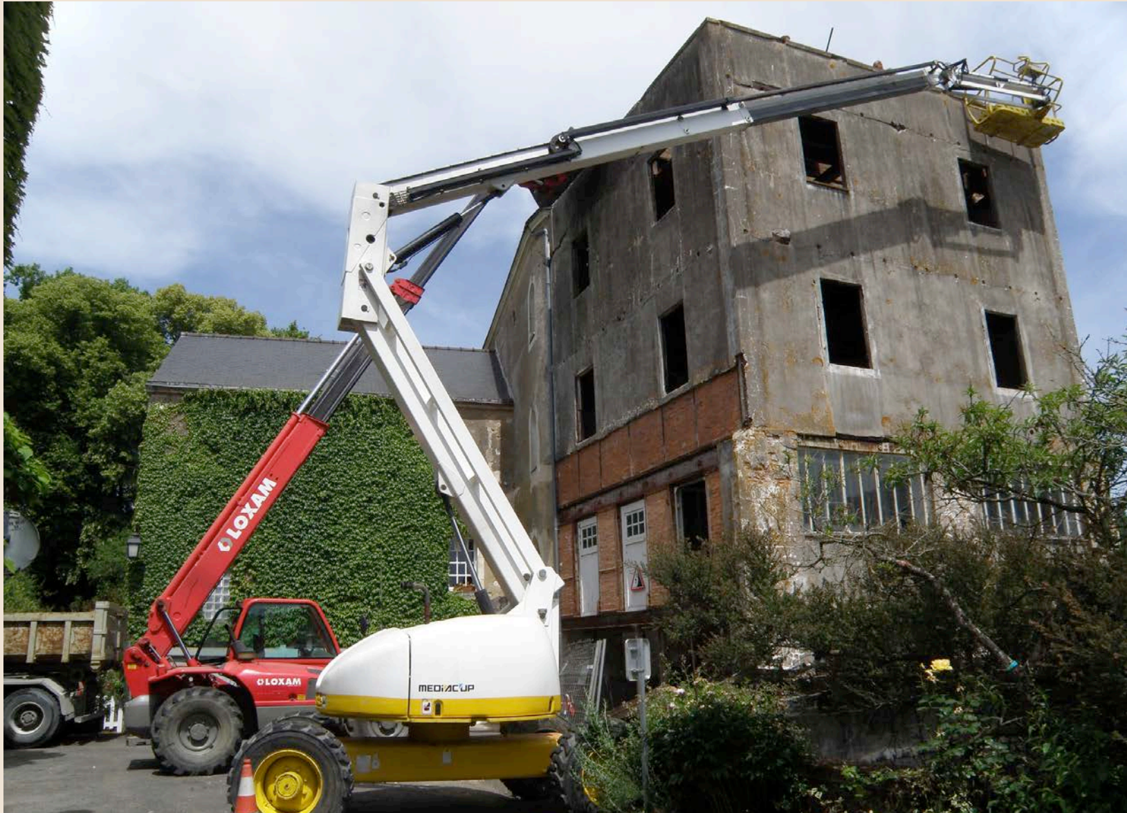
Déconstruction façade sud
