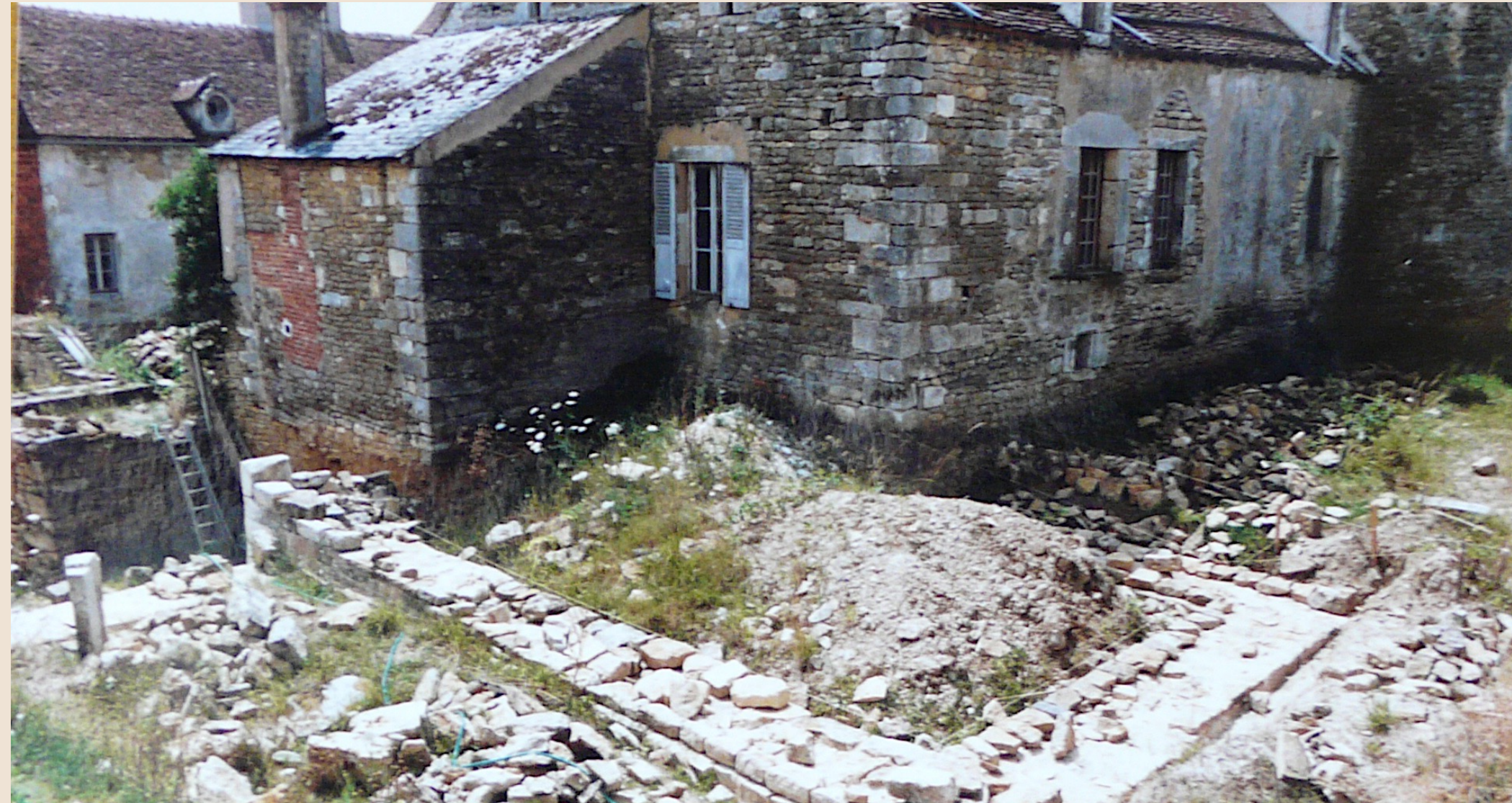
Emplacement de la tour d'angle et embase de la petite tour (près de l'échelle)
