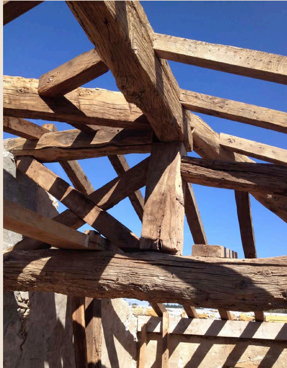
Restauration de la charpente avec du bois de récupération.
