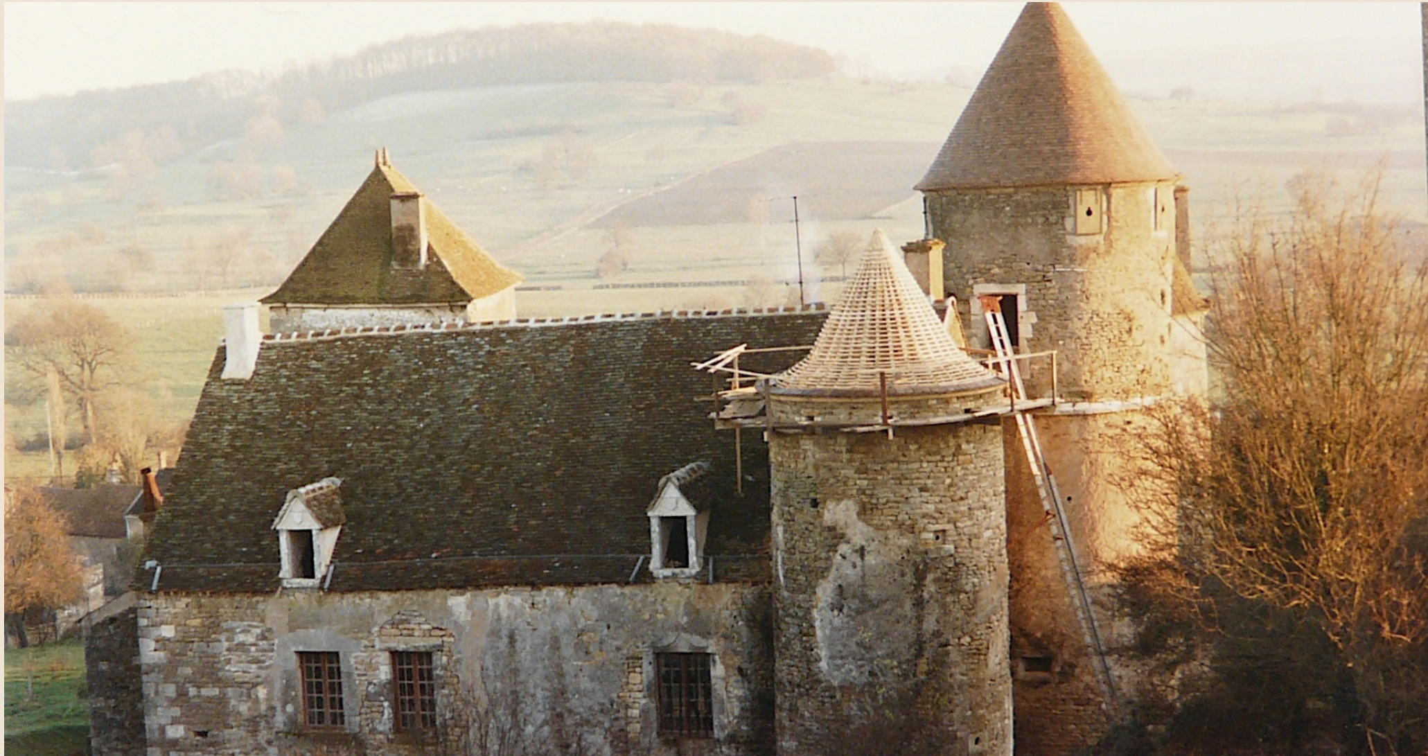
Toiture tour d'angle ouest
