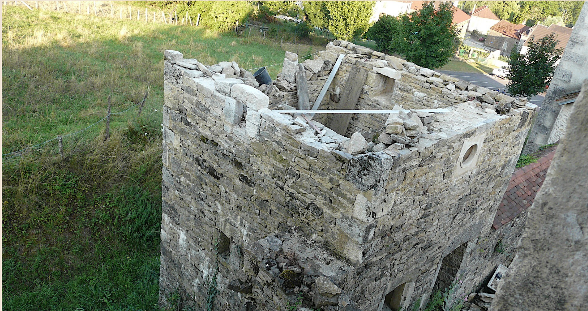
Construction petite tour nord
