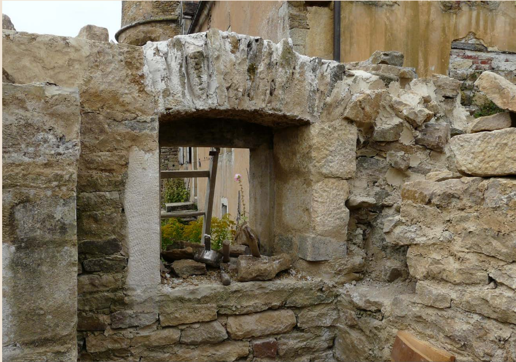
Construction petite tour nord
