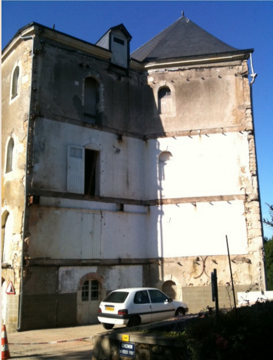
Façade sud après démolition
