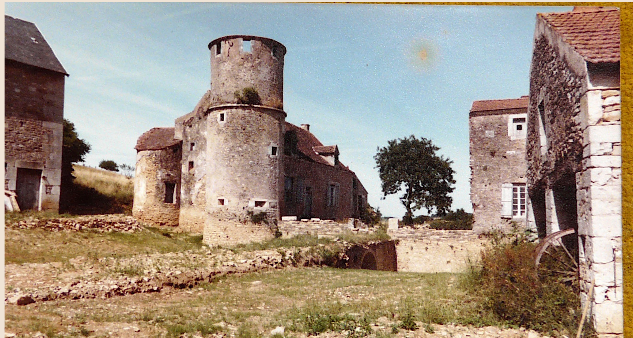
Dégagement des douves et remblais - ouest
