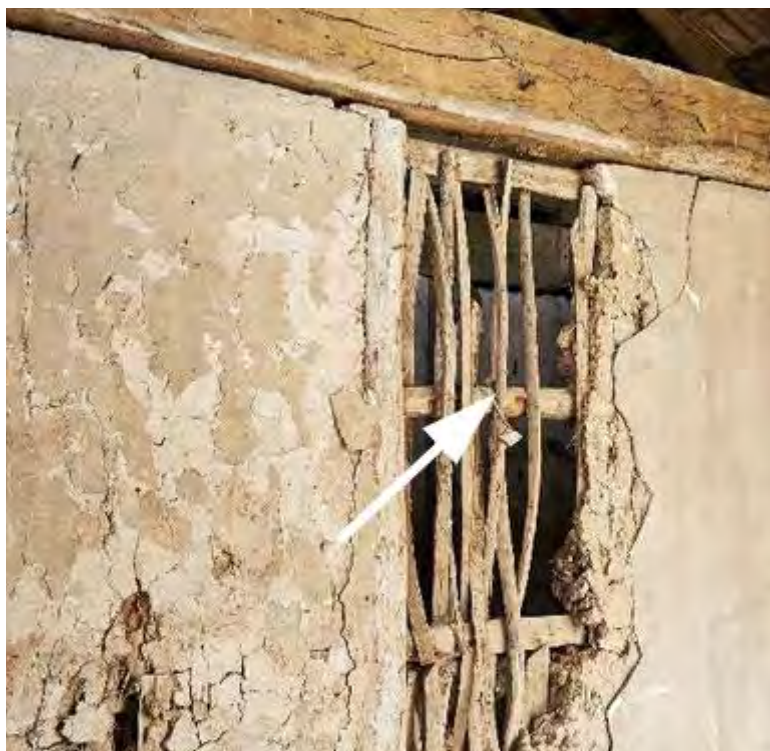
Illustration 24: Clayonnage composé de palançons horizontaux en première trame et de baguettes verticales en 2e trame. (©Région Grand Est - Inventaire général/Ph.B.Drapier)
