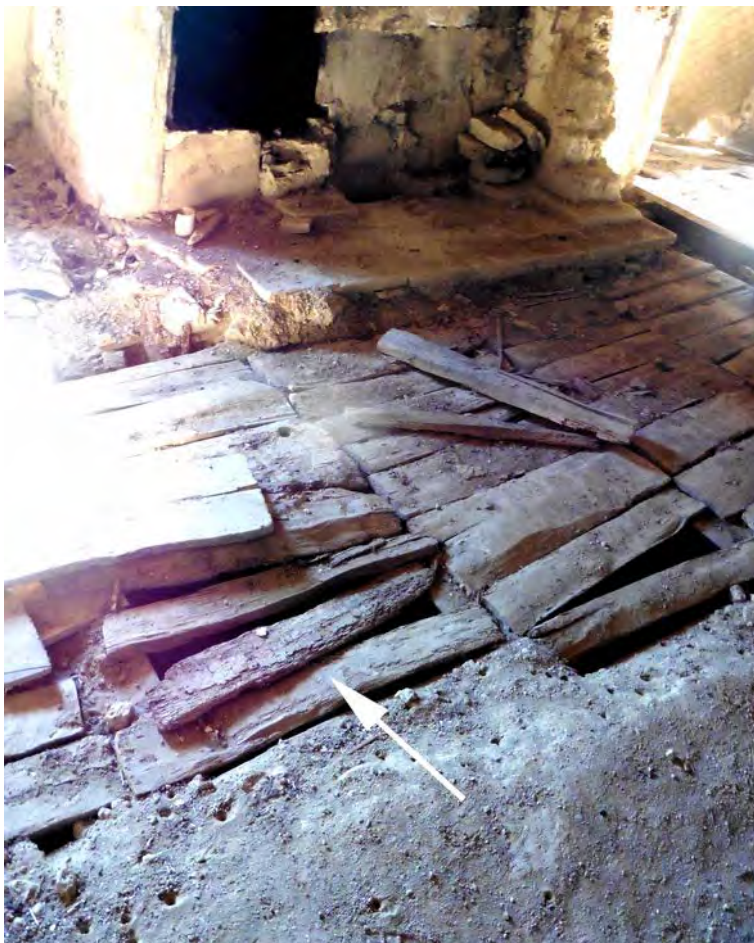
Illustration 3: Plancher de palets, support d'une chape de torchis, vu par dessus (Gers). (Sophie Popot)
