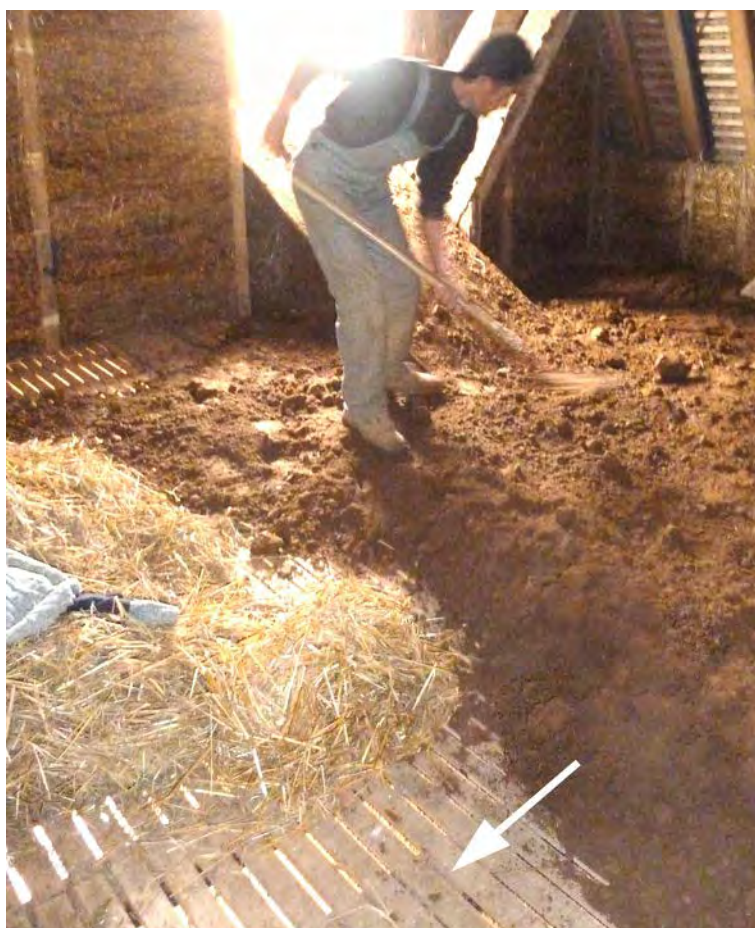
Illustration 26: un lattes au sol formant plancher non jointif, vu de dessus. Avant la pose de la chape sèche (Sophie Popot)
