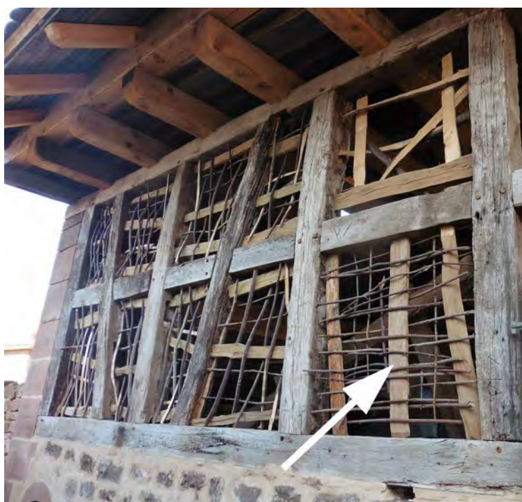
Illustration 23: Clayonnage composé de 3 palançons verticaux en première trame et de baguettes croisées en 2e trame en Alsace. (Sophie Popot)
