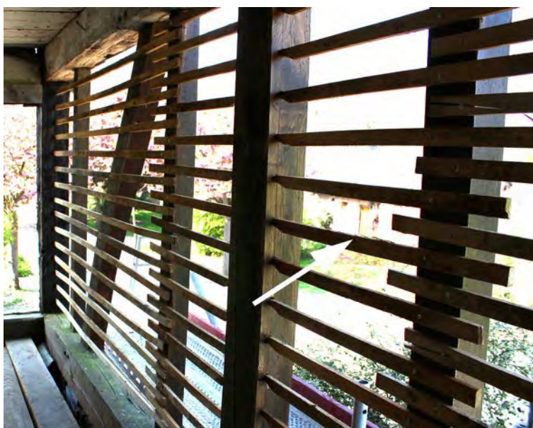
Illustration 16: Lattage formant lattis par endroit (Yan Minne)
