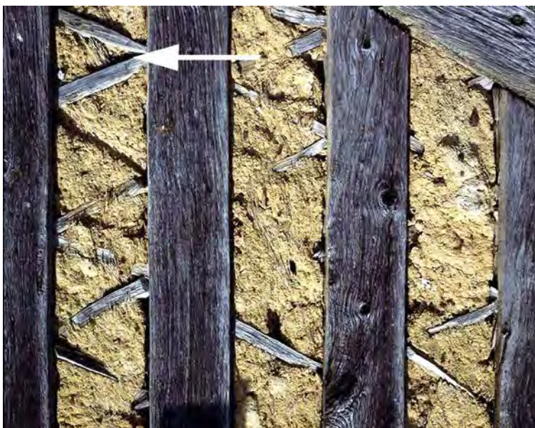
Illustration 10: des éclisses posées en zig-zag (© Région Centre-Val de Loire, Inventaire général, Robert Malhoury)
