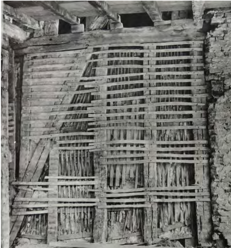
Illustration 25: Une paroi avec une combinaison de deux types de support de fixation, clayonnage vertical entre bois d'ossature, lattis horizontal sur le colombage (© Médiathèque de l'architecture et du patrimoine (Centre de recherche des monuments historiques - CRMH) diffusion RMN Daniel Bontemps
