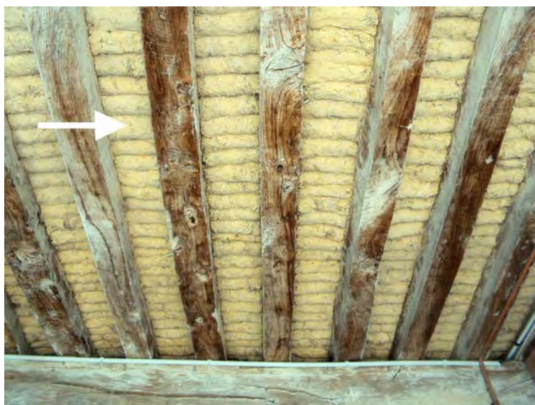
Illustration 1: Andouilles achevées et bien serrées, vues par dessous en Normandie. (Aurélie Le Pape)
