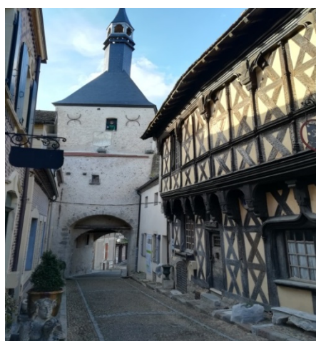
Maison à pans de bois
