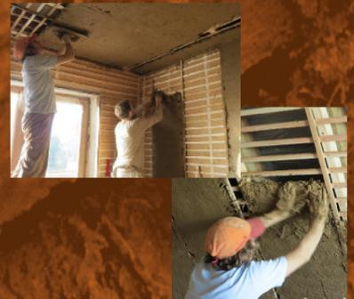
>> **En réhabilitation** : Une ossature bois secondaire fixée sur un mur maçonné, reçoit une isolation naturelle, la finition est assurée par un torchis allégé en 4 cm posé sur lattis, tant sur les murs qu'en plafond et sous rampants où il sert alors de coffrage perdu pour insuffer la ouate de cellulose tout en assurant la finition.
