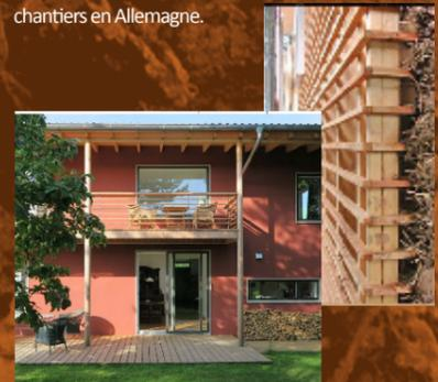
>> **En construction neuve** : le terre/paille coffré en extérieur est utilisé sur une faible épaisseur (12 cm au total) et ne constitue alors que le parement extérieur du bâtiment à ossature bois. Il est associé sur sa face interne à un complexe isolant naturel qui reçoit une finition en Fermacel par souci d'économie, (la finition pourrait être constituée par un enduit terre).
