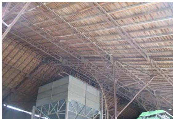
fig. 18. Charpente métallique type Eiffel du XIXème siècle (exploitation F / source EBA 77)
