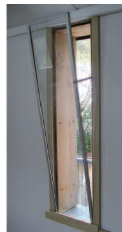
Un double vitrage simplement retenu par une patte.
