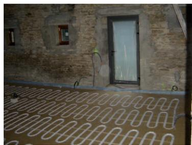
Les serpents du chauffage électrique au sol avant leur recouvrement par les dalles de calcaire.
