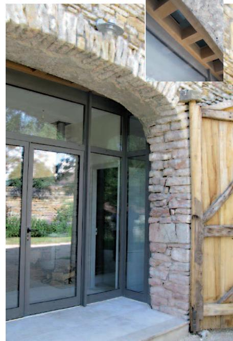
Les portes extérieures de bois de la grange ont été reconstruées. Une menuiserie intérieure de verre sur montants d'aluminium laqué a été construite en retrait pour ménager un abri et réduire au maximum les reflets.
