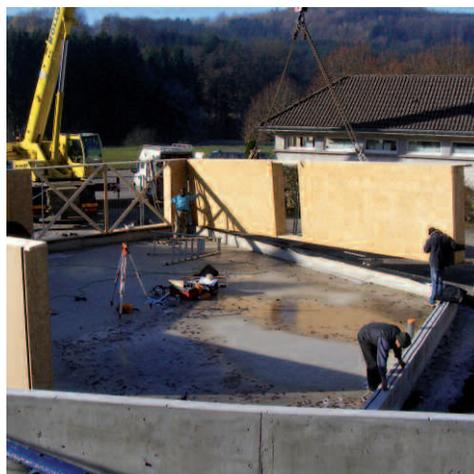
Pose des murs caissons sur chantier.
