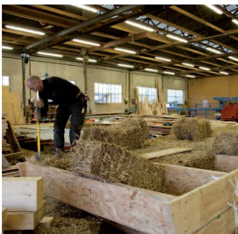
Montage des murs chez le charpentier. Remplissage paille.
