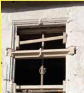
Cette maison qui figure dans les archives d'Orléans au XV<sup>ème</sup> siècle a retrouvé son aspect Renaissance grâce à la restitution de ses fenêtres à meneaux et la création d'ouvertures dans la façade intérieure côté cours. La réfection des enduits et d'une partie de la couverture en ardoise à l'identique rétablissent le statut social de cette demeure.
