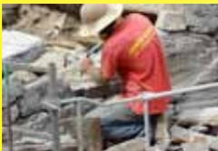
Le projet est lancé et réalisé : la maçonnerie est de schiste à liant chaux hydraulique, les fondations ont été maçonnées avec un mortier bâtard du fait de l'importance d'un durcissement rapide en milieu humide.
